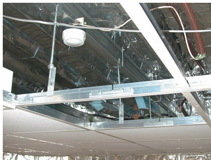
図 4-3 天井板と吊り金具
