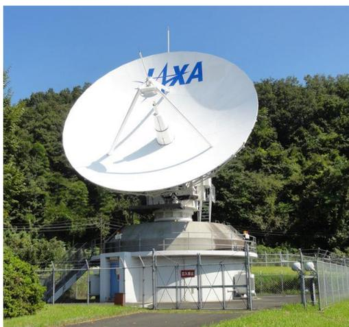
図15 「こだま」電波の受信アンテナ（JAXA地球観測センター：第4アンテナ：直径13m）
